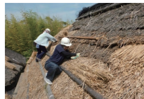
万代順四郎旧宅(横須賀市) 茅葺きボランティア修理、平成28(2016)年
