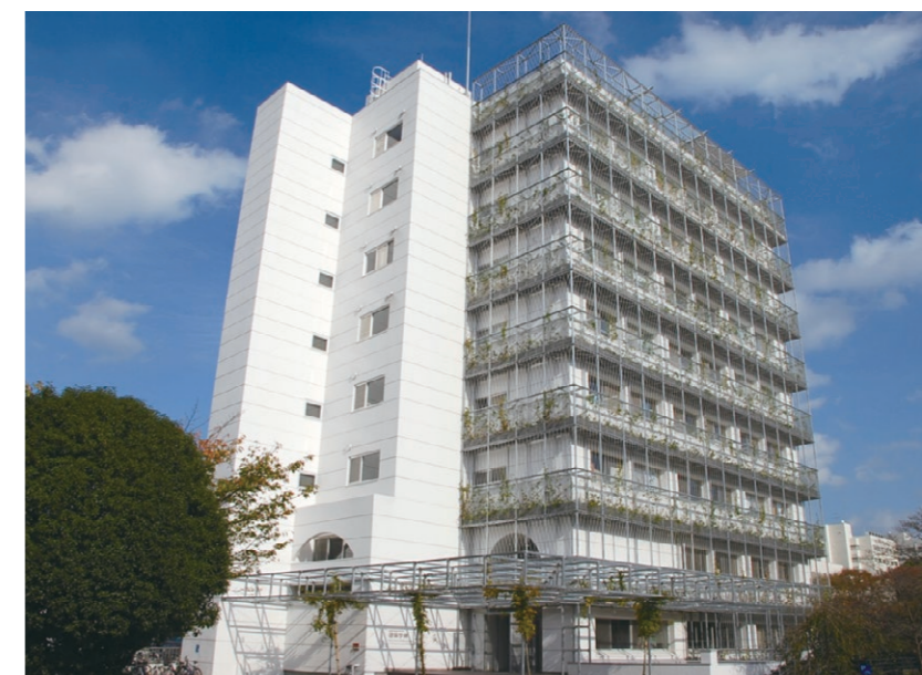
リニューアル後の建築学棟
