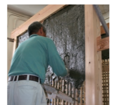
土塗り壁の施工
