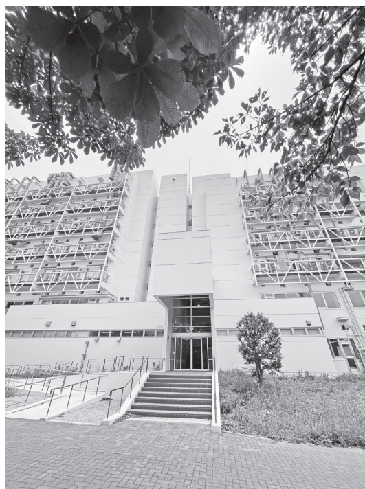
改修後の化学棟正面入り口
