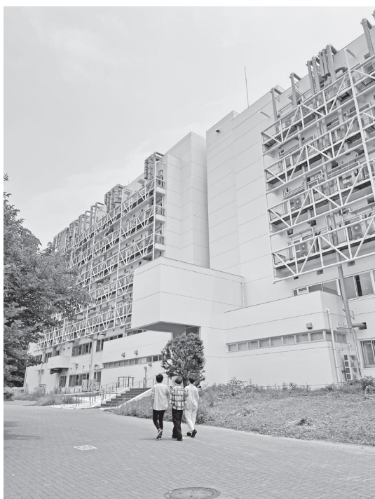
改修後の化学棟
