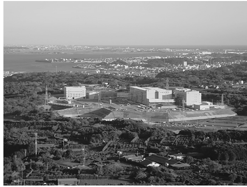
建設中の新本社工場（静岡県湖西市）
