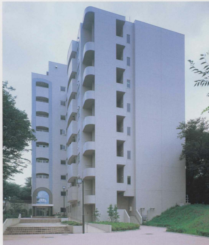
1 2000年4月に竣工した人工環境システム工学棟
